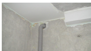
Vid avfuktning av fuktskadade badrum kan det se ut så här.
